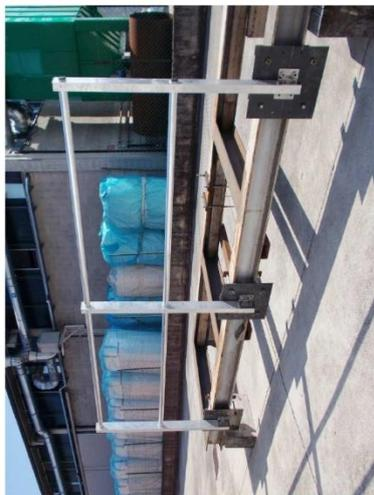
Allestimento parapetto PROCT. Distanza montante-montante 1,5 m
